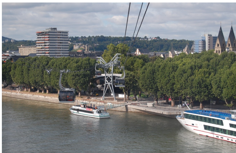
Télécabine tricâble 3S de Coblenz - Allemagne (photo Doppelmayr)
