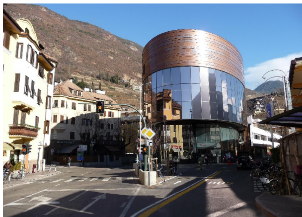
Station aval de la télécabine bicâble de Bolzano (photo Leitner)
