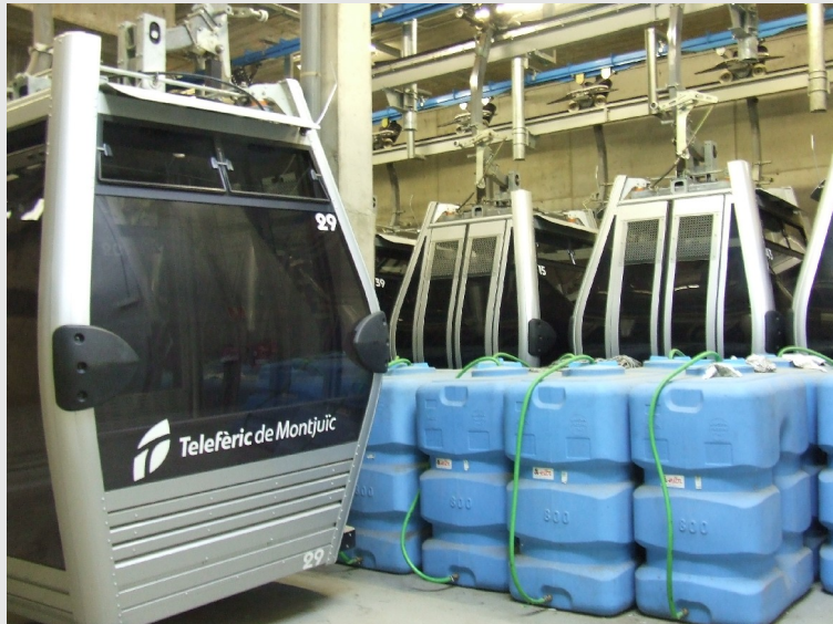
Barcelone : salle de maintenance de la télécabine de Montjuïc (photo Anne Le Ruyet - CETE de Lyon)
