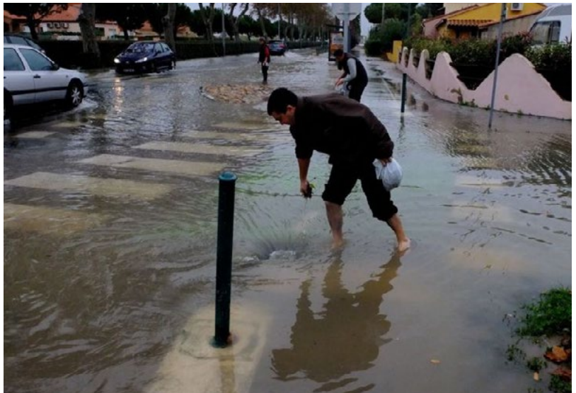
Les plaques d'égouts peuvent s'enlever et créer des pièges par aspiration.
